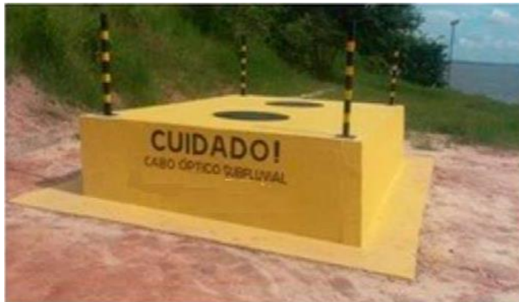
Figura 2. Imagem externa de uma caixa de ancoragem finalizada e identificada.
