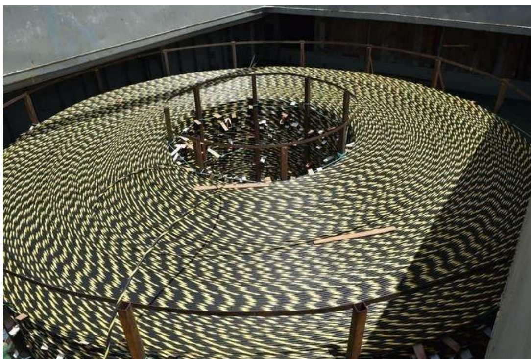
Figura 6. Bobina de cabo acomodada em Cesto na embarcação de lançamento (PAC-2) – Fonte: foto EB.
