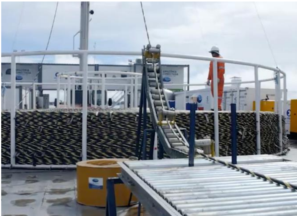
Figura 15. Infraestrutura mecânica especializada para deslize do cabo óptico no rio.
