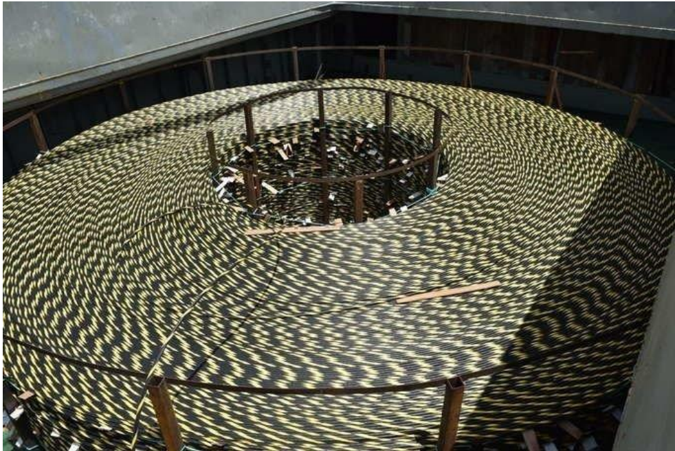
Figura 14. Bobina do cabo óptico na embarcação para lançamento (PAC-2) – Fonte: foto EB.
